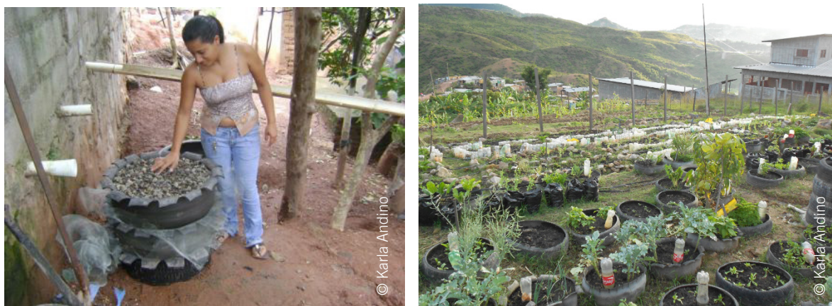
Figura A.1. Filtro de aguas grises (izqda.) y huertos regados con aguas grises en Suyapa, Honduras (dcha.).
