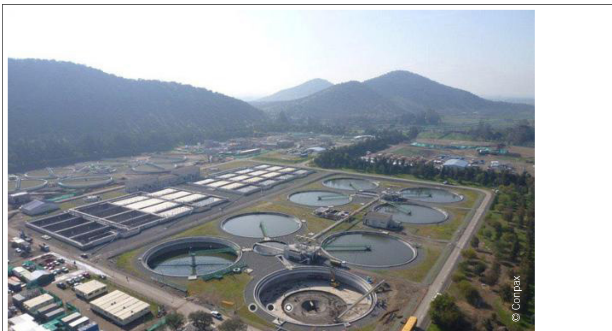
Figura 5.2. Construcción de la planta de tratamiento de aguas residuales Mapocho, finalizada el año 2012. (Fuente: Conpax, 2012)
