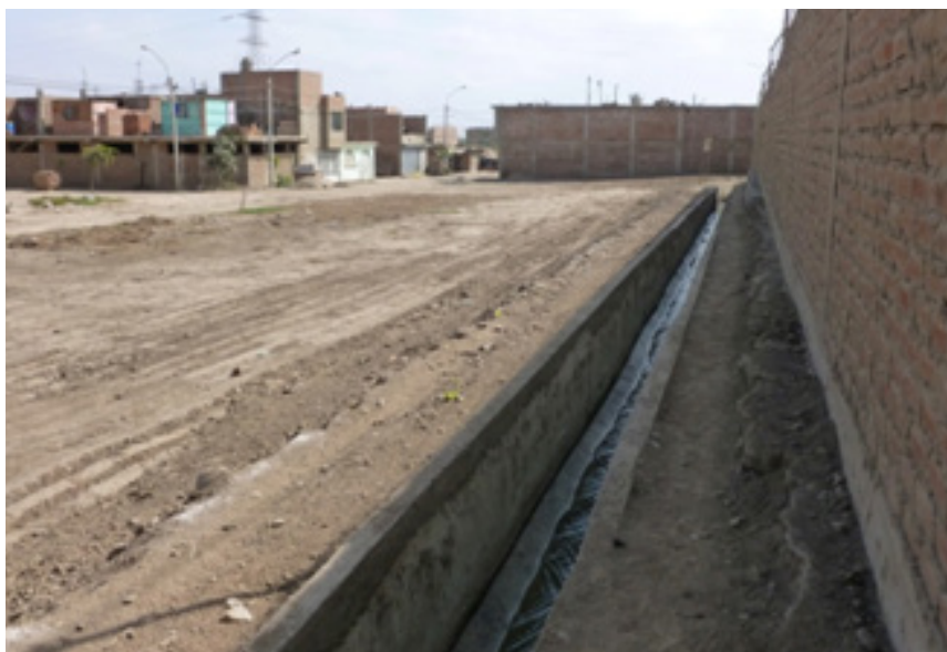
Figura 2: Asentamiento La Florida II: canal de irrigación San José y zona del proyecto a la izquierda del canal, antes de su construcción (Fotografía: Eva Nemcova)
