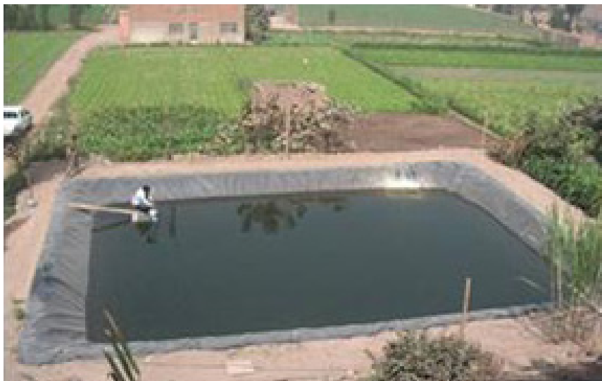
Figura 1: Primer reservorio construido en el Este de Lima
