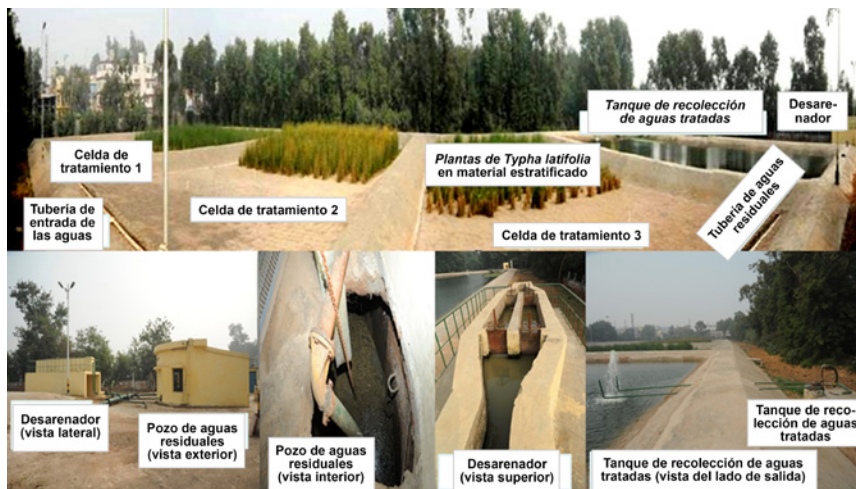
Figura 2: Vista panorámica de la planta de tratamiento ecológico de aguas residuales municipales (ampliada) y los componentes
