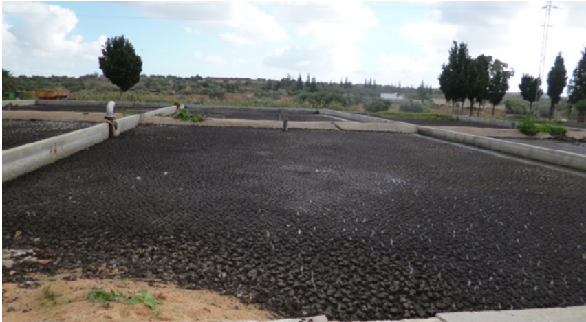
Figura 4: Lodos residuales en lechos de secado en la PTAR de Ouardanine (con autorización de O. Mahjoub, 2015)
