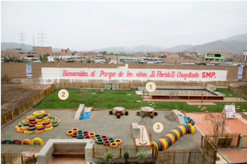
Figura 3: Parque de los niños: parque de tratamiento de aguas residuales, en el día de su inauguración en agosto del 2014; incluye: 1) sistema de tratamiento con humedal artificial y reservorio, 2) espacio verde recreativo con árboles frutales y 3) área de juego con superficies secas (Fotografía: Evelyn Merino Reyna)
