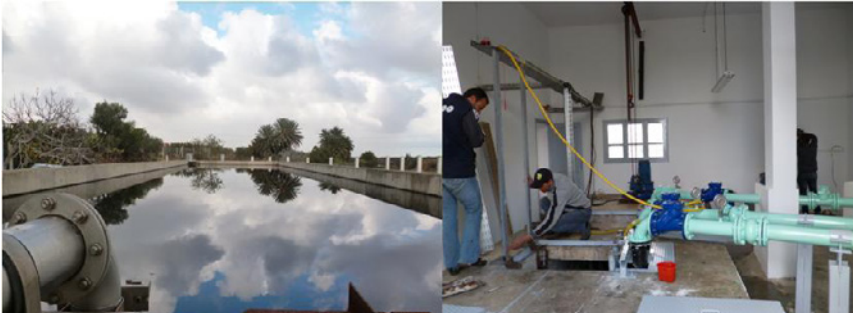
Figura 6: Embalse de 1000 m 3 y mantenimiento de la estación de bombeo en Ouardanine (con autorización de O. Mahjoub, 2015)
