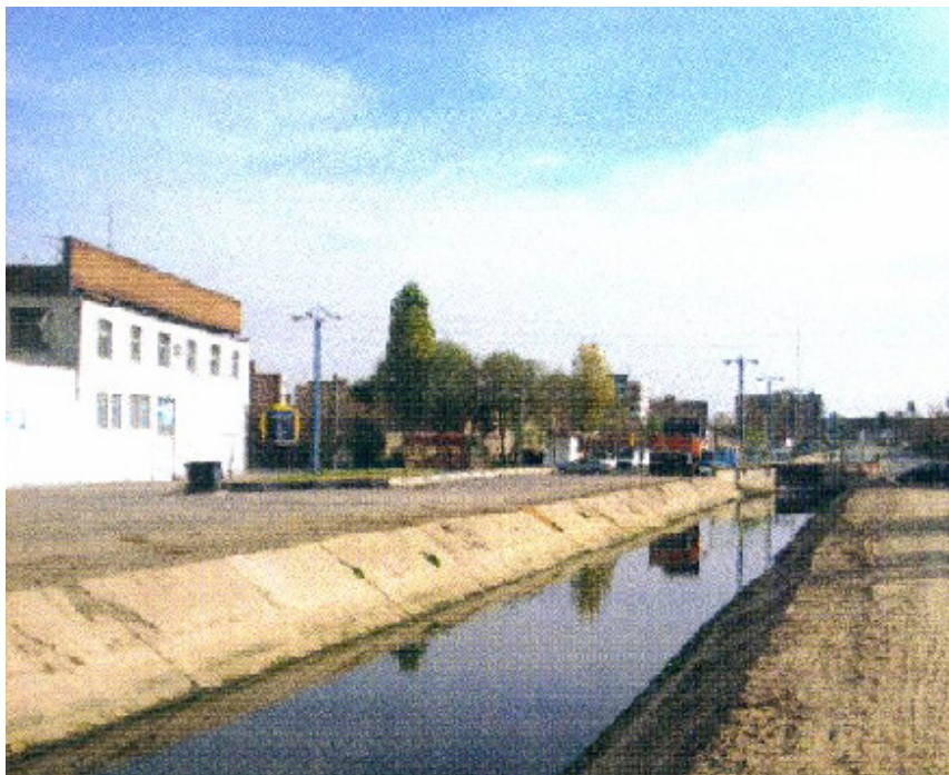
Figura 5: Canal de Teherán atravesando una zona residencial (Tehran Sewerage Company, 2012)
