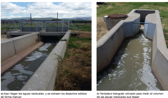
Figura 2: Cribado de los desechos sólidos y vertedero triangular en la planta de tratamiento de aguas residuales de Lebowakgomo
