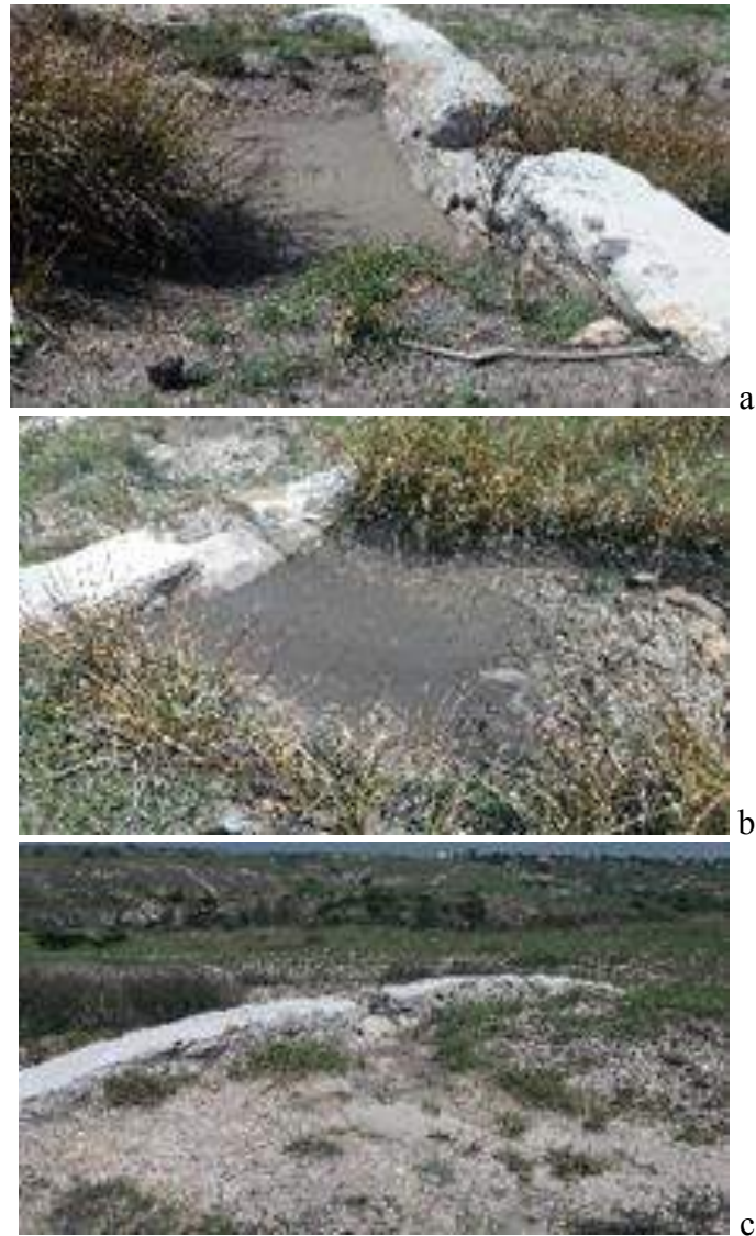
Figura 5. Represa de mampostería I. Máxima captadora de suelo y agua entre las represas (a). Represa de mampostería II. Segunda captadora de suelo y agua entre las represas (b). Represa de mampostería IV, la que menos suelo retiene entre las cuatro represas (c).
