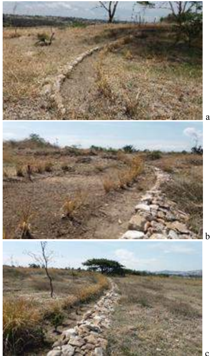
Figura 2. Muro de piedras acomodadas III (a). Área de recolección de suelo atrapado por el muro de piedras acomodadas II (b). Muro de piedras acomodadas I (c).
