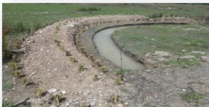
Figura 1. Zanja trinchera para la captación de agua de lluvia y retención de suelo
