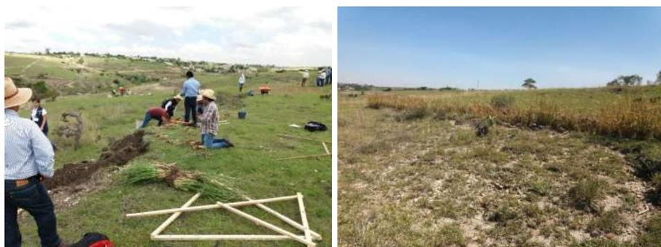
En los contornos con erosión fuerte y muy fuerte, con pendientes de 5% a 10% y cubrimiento de la cobertura vegetal entre 40% y 60%, se construyeron muros de piedras acomodadas protegidos, represas de mampostería y zanjas trincheras para la retención de suelo y captación de agua de lluvia (Figura 4). En esta microcuenca se concentra el agua de lluvia que antes corría libremente hacia la presa y hoy suelo y agua son retenidos por la obras construidas.
