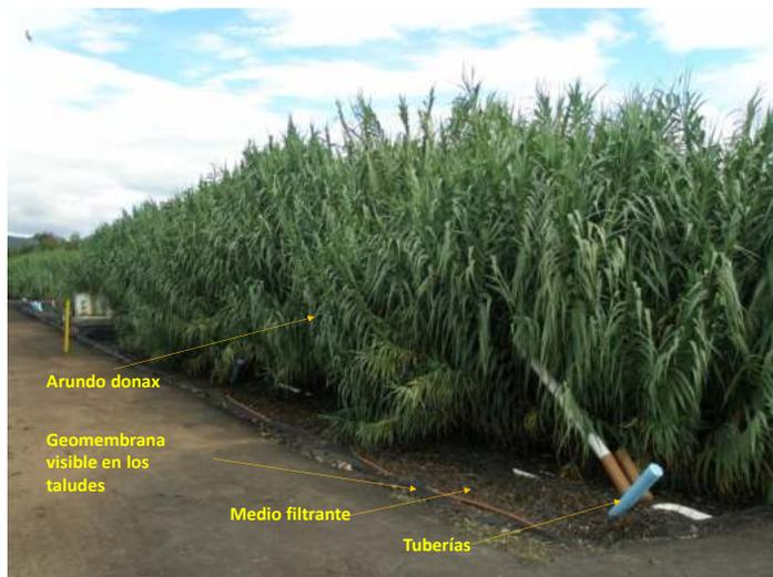
Los estanques con plantas deben estar precedidos de un tratamiento previo para la eliminación de basuras (sistema de rejillas), arenillas y otros sólidos (desarenador), y grasas y aceites (trampa para grasas); así como de un tanque séptico o algún otro proceso anaerobio (ausencia de oxígeno), como puede ser un biodigestor, un reactor anaerobio o un tanque Imhoff, para remover materia orgánica y sólidos en suspensión (García *et al.* 2004).
