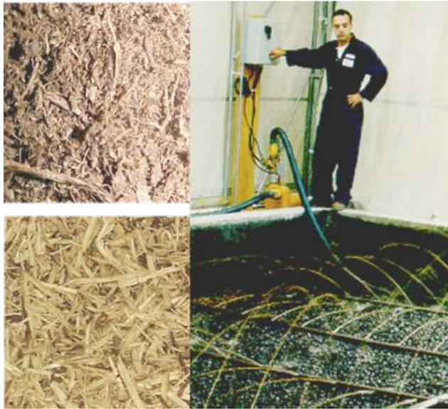
Figura 4. A) Astillas de madera utilizadas como material filtrante en biofiltro sobre las cuales crece la biopelícula; B) la biopelícula compuesta por diferentes grupos de microorganismos especializados en la degradación de diferentes contaminantes
