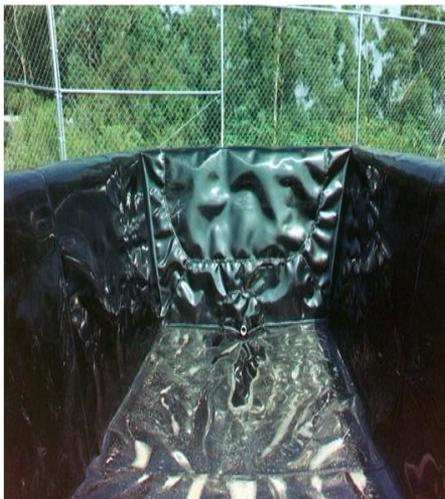
**Figura 6.** Alberca ya cubierta (en este caso con plástico negro del que se usa para cubrir el suelo en los tiraderos de basura)
