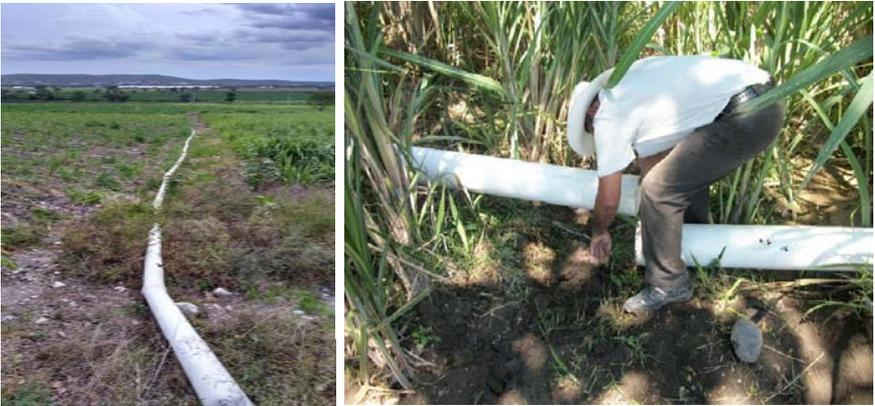
**Figura 11.** Instalando el sistema de multicompuertas.
